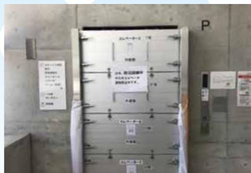
止水板設置時のエレベーター
