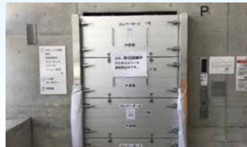
止水板設置時のエレベーター
